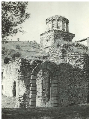
3, Bivongi (Reggio Calabria), San Giovanni Theristes, 1122 circa, veduta absidale con il portale di accesso al monastero, non più esistente
